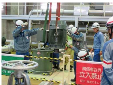
直営による堅型ポンプ用電動機を取替作業
