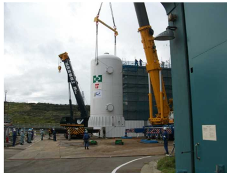
フィルタベント設備の搬入・設置 (柏崎刈羽7号機)
