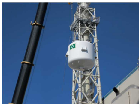
よう素フィルタの搬入・設置 (7号機)
