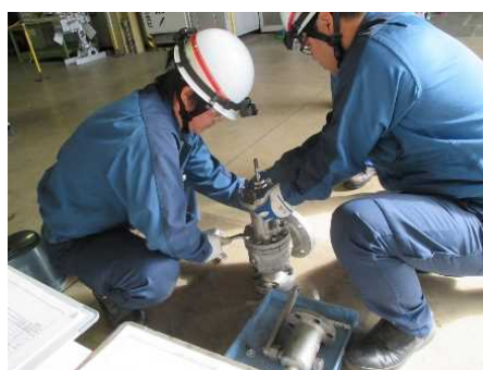
直営による安全弁の分解点検
