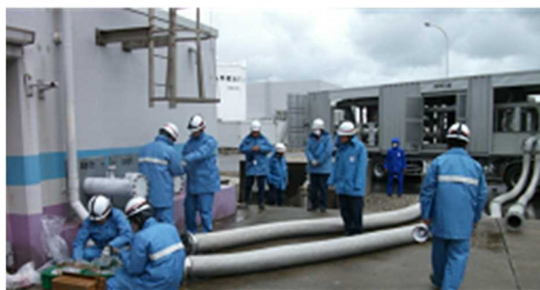
代替原子炉補機冷却系熱交換器ユニット等の接続訓練
