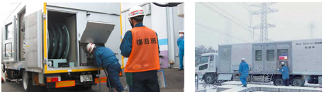
代替交流電源設備（ガスタービン発電機車、電源車）の接続訓練
