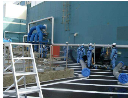
代替原子炉補機冷却系熱交換器ユニット等の接続訓練
