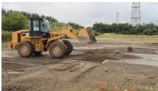
段差復旧状況③
