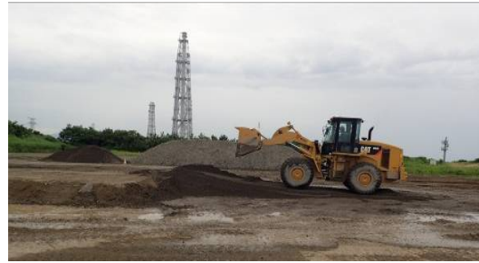
図6 段差復旧状況
