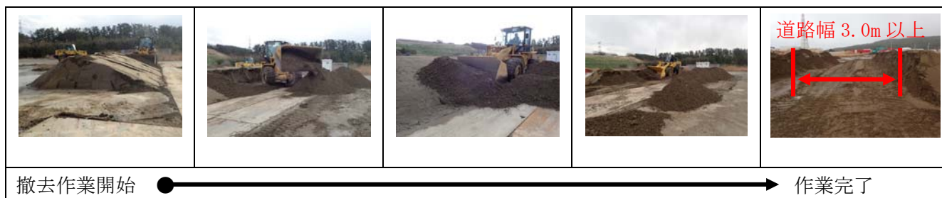
図 9 崩落土砂撤去状況写真
