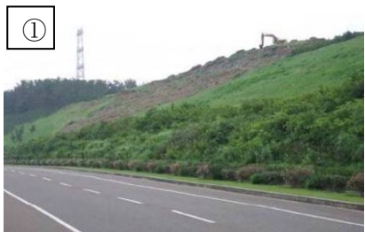
土捨場北側斜面（近景）
