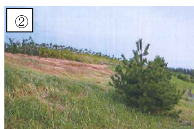
大湊側高台保管場所西側斜面（近景）
