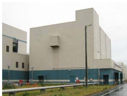
雑固体廃棄物焼却設備建屋 (大湊側)
