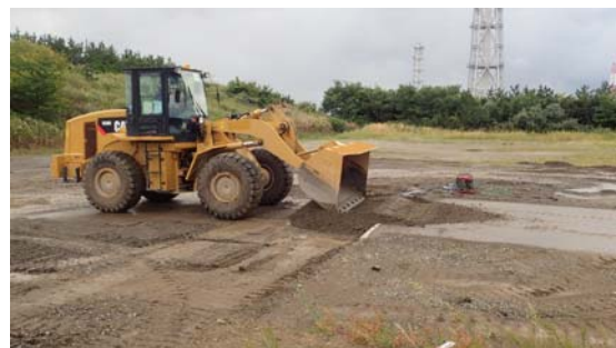
段差復旧状況②
