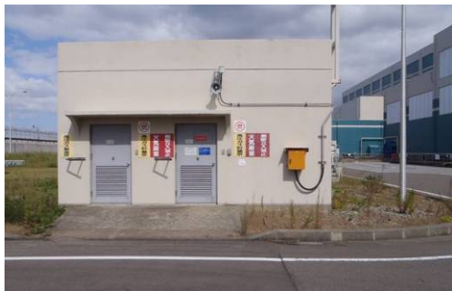
発電機用水素ガスボンベ建屋 (6号炉)
