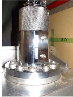
遠隔手動弁操作設備のリンク機構
