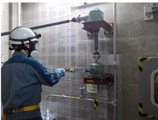
原子炉格納容器ベント操作(遠隔手動弁操作設備)
