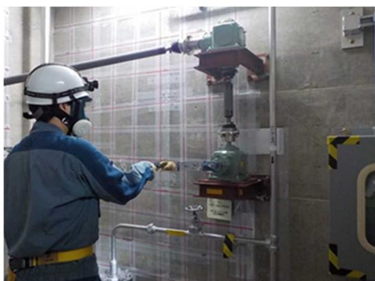
原子炉格納容器ベント操作(遠隔手動弁操作設備)
