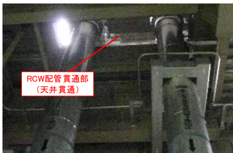
原子炉補機冷却水系配管貫通部 (天井貫通) 現場状況
