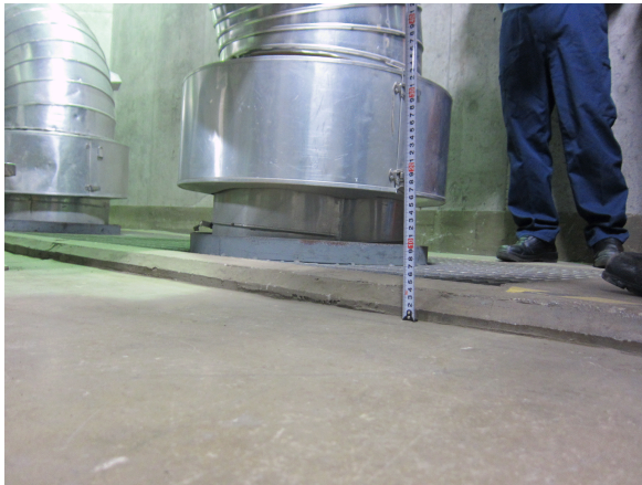
第 2.3-4 図 原子炉補機冷却海水系配管貫通部（6号炉）
