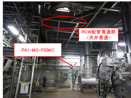
P21-MO-F007C.F 現場状況
