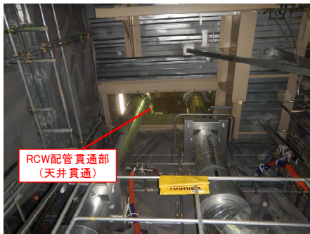
原子炉補機冷却水系配管貫通部 (天井貫通) 現場状況
