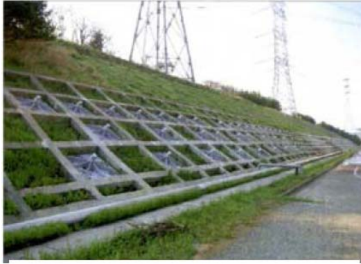
超高圧開閉所東側法面
