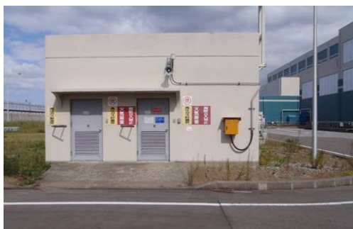
発電機用水素ガスボンベ建屋 (6号炉)
