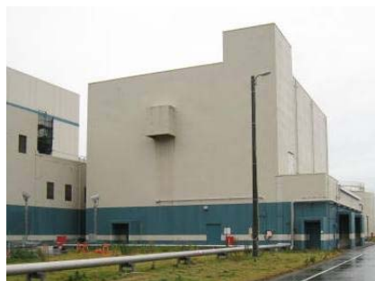
雑固体廃棄物焼却設備建屋 (大湊側)
