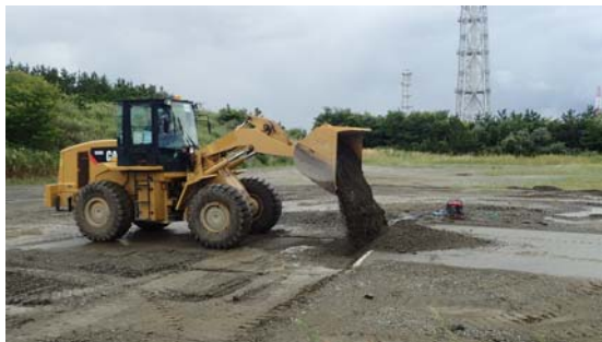
段差復旧状況①
