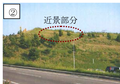
大湊側高台保管場所西側斜面（遠景）
