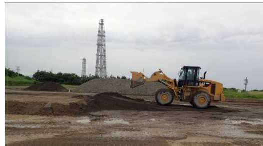
図6 段差復旧状況
