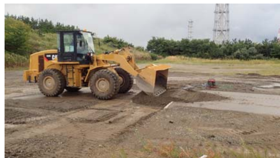
段差復旧状況②
