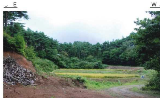
地すべり写真 c 地すべり土塊 (A) と (B) との間の溝状の凹地。
