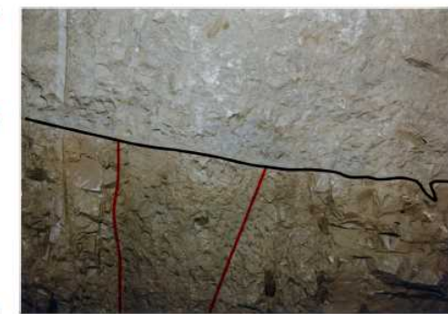
3V-1坑最終切羽拡大写真
