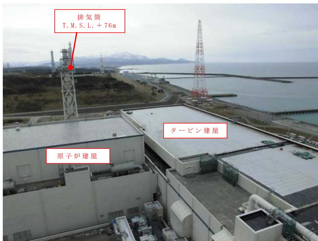
第 4.3-2 図 津波監視カメラ設置位置
