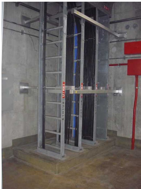
第2-1図 ケーブルトレイ床貫通部外観
