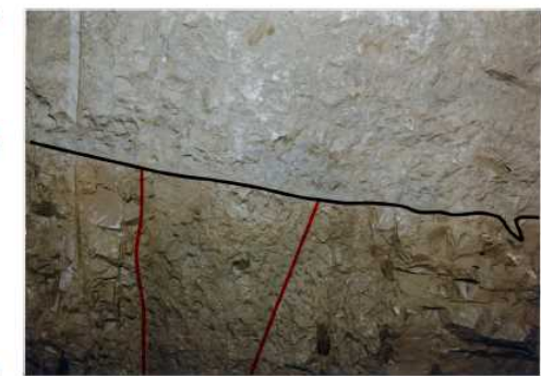
3V-1坑最終切羽拡大写真
