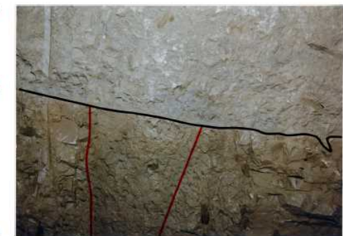
3V-1坑最終切羽拡大写真
