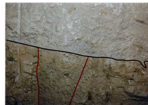
3V-1坑最終切羽拡大写真
