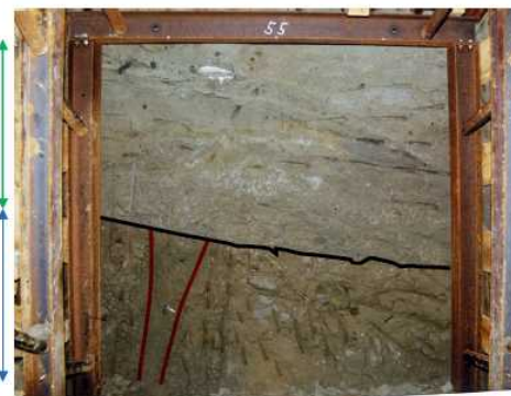
3V-1坑最終切羽写真
