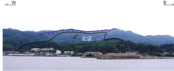
地すべりの全景写真 a
