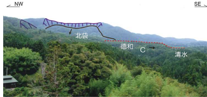
地すべり土塊 (B) 及び (C) の全景写真 b
