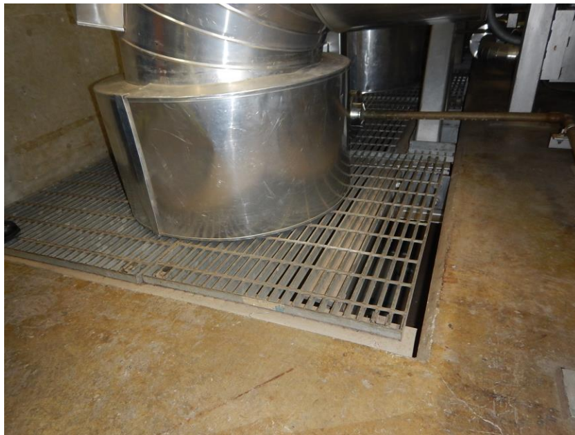
第 2.3-3 図 原子炉補機冷却海水系配管貫通部（7号炉）
