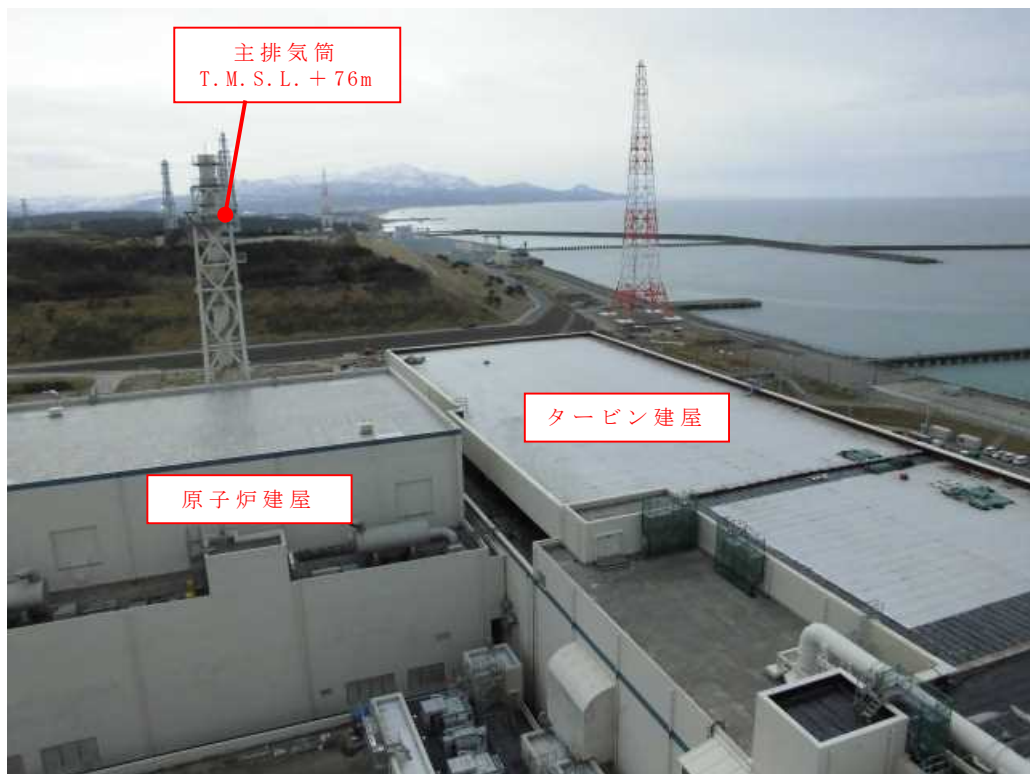
第 4.3-2 図 津波監視カメラ設置位置
