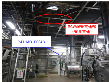
P41-MO-F004C 現場状況
