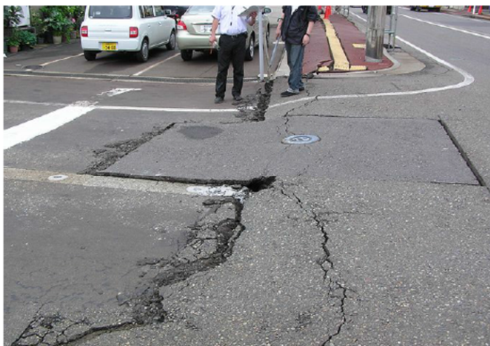
第 11-11-27 図 砂丘肩部分に現れた亀裂開口 (土木学会 (2010) に一部修正)
