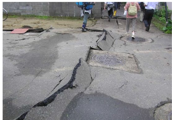
第 11-11-28 図 砂丘麓部分の圧縮痕 (土木学会 (2010) に一部修正)
