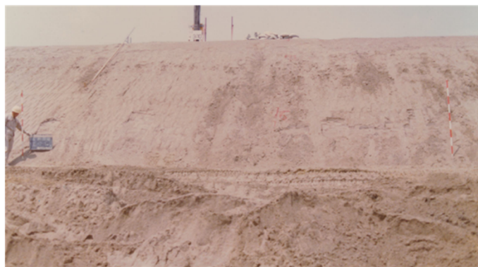
1号海水機器建屋西側法面 T.M.S.L.+3m~-2m 新期砂層・沖積層 (地点①)
