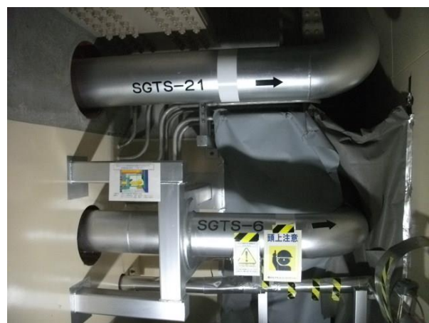
配管補修箇所（可搬型照明2台使用）
