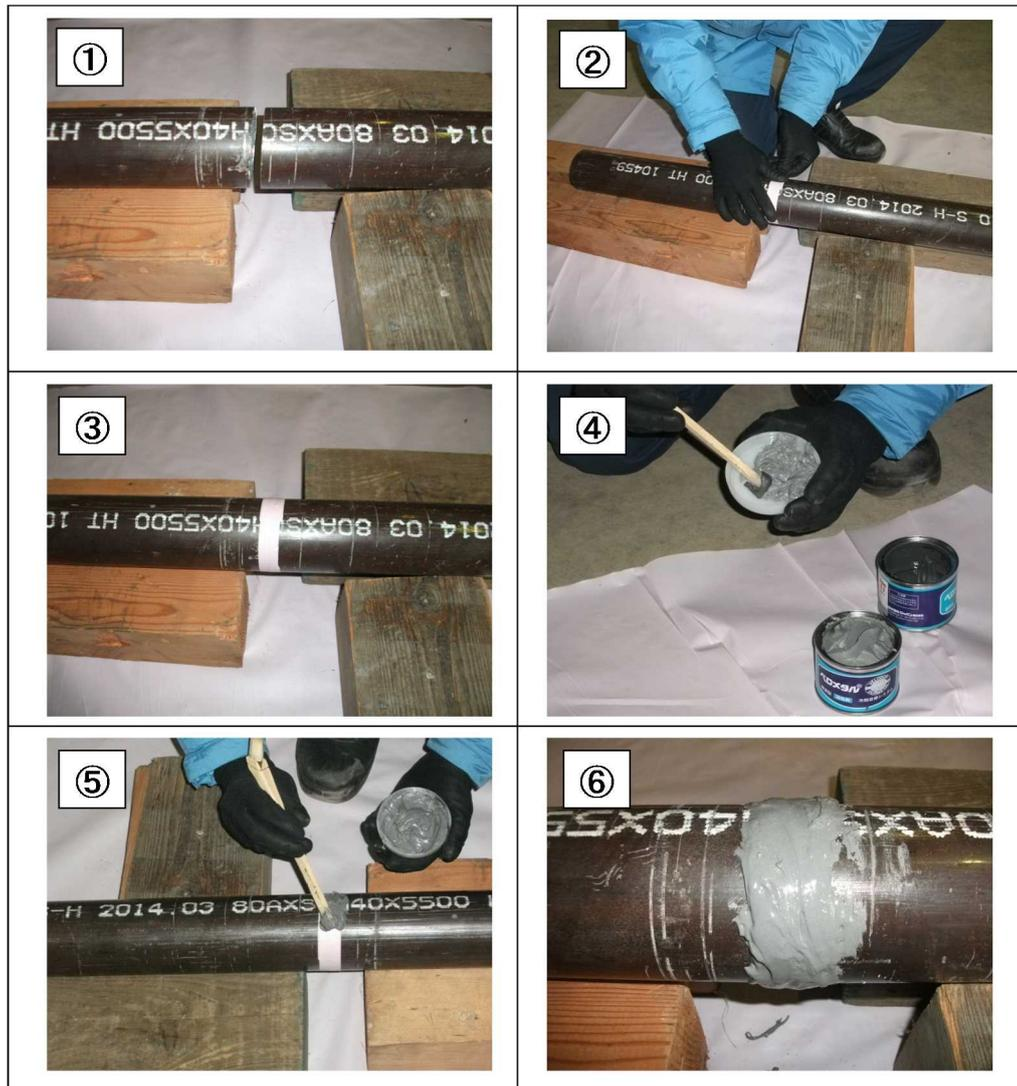
図 2.1.2-4 ペロメタル補修の例示
