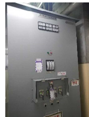
CRD 駆動水加熱器盤
