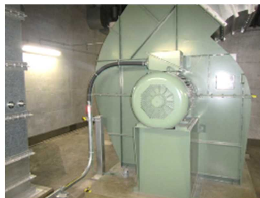
送風機、電動機及び可とう電線管
