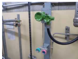
原子炉系多重伝送現場盤
