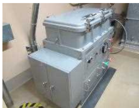
ダストサンプラ及び可とう電線管
