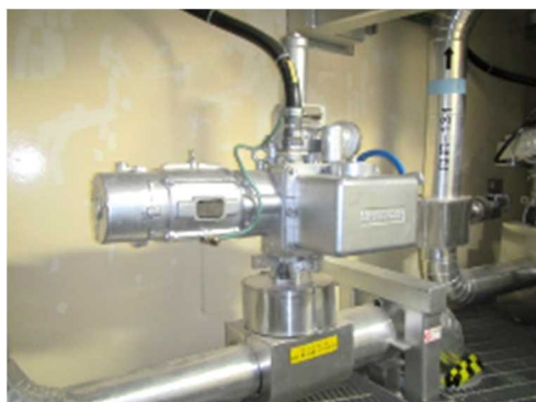
電動弁及び可とう電線管
