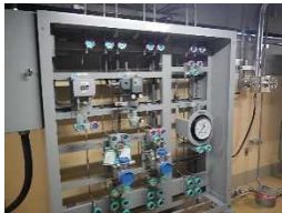
サンプリングトランスミッタ盤
