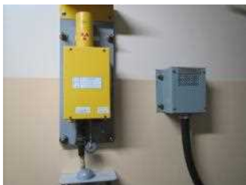
エリアモニタ及び可とう電線管
