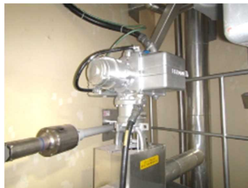
電動弁及び可とう電線管
