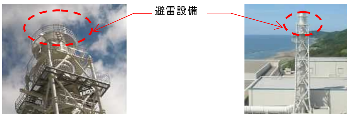
第 1-16 図：避雷設備の設置例（主排気筒）
