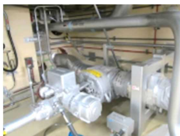
電動弁及び可とう電線管
