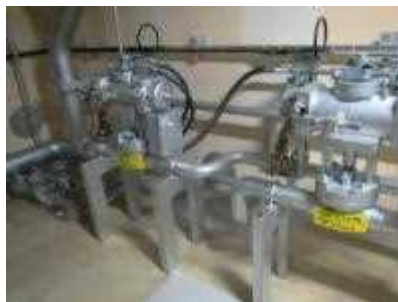
空気作動弁及び可とう電線管
