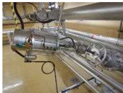
空気作動弁及び可とう電線管
