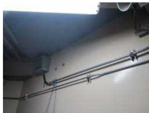
エリアモニタ及び可とう電線管
