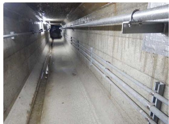
配管及び電線管
