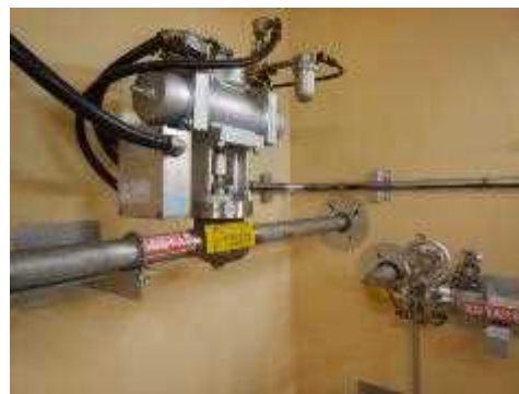
空気作動弁及び可とう電線管
