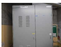
原子炉系多重伝送現場盤
