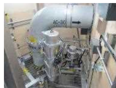
空気作動弁及び可とう電線管
