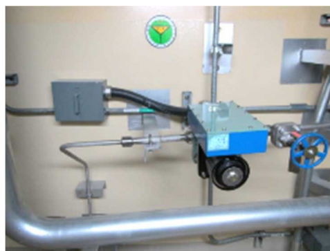
電磁弁及び可とう電線管
