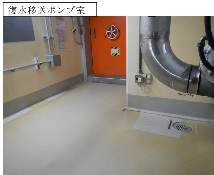
第 1-2 図：堰による拡大防止対策概要図
