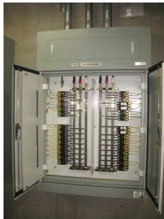
配線用遮断器の例 (ブレーカー)
