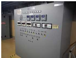
サンプリングトランスミッタ盤
