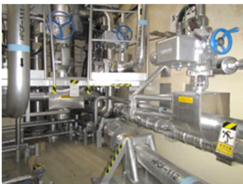
電動弁及び可とう電線管
