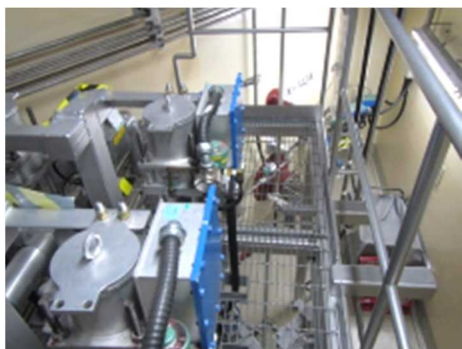
空気作動弁及び可とう電線管
