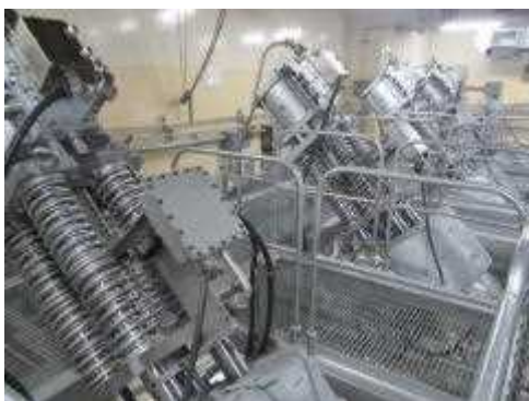
主蒸気隔離弁
