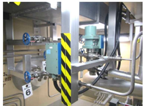
電磁弁及び可とう電線管
