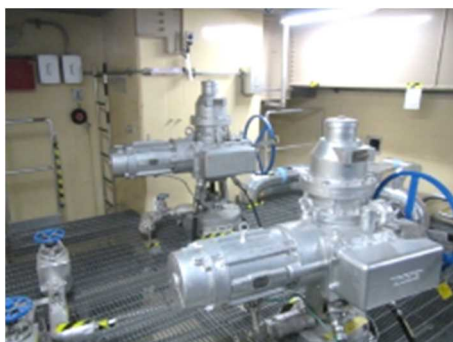
電動弁及び可とう電線管
