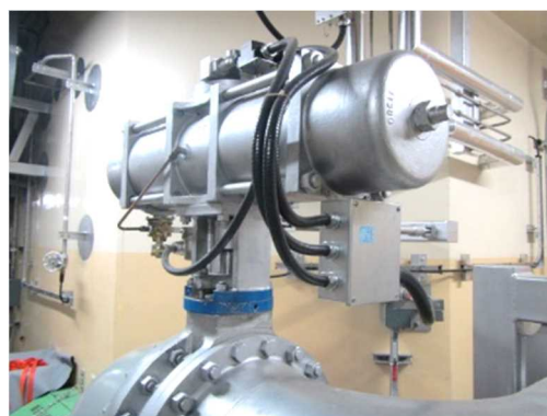
空気作動弁及び可とう電線管
