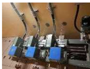
TIP 駆動装置及び可とう電線管
