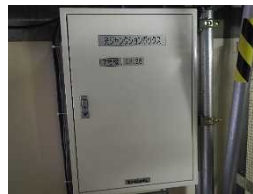
原子炉系多重伝送現場盤
