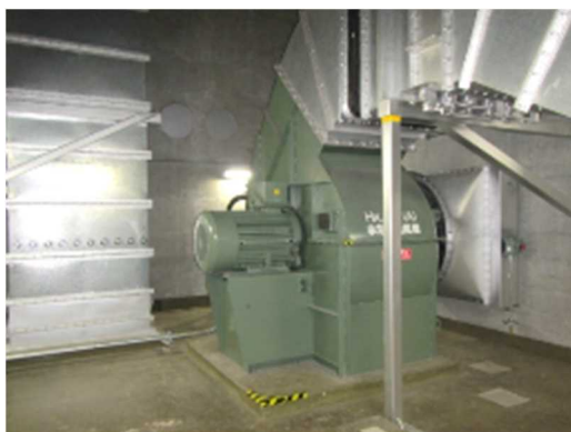
送風機、電動機及び可とう電線管
