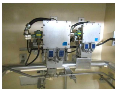
空気作動弁及び可とう電線管
