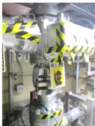
電動弁及び可とう電線管
