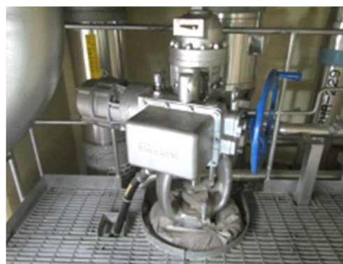
電動弁及び可とう電線管
