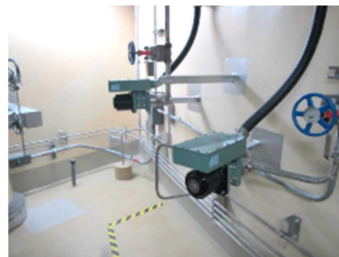
電磁弁及び可とう電線管
