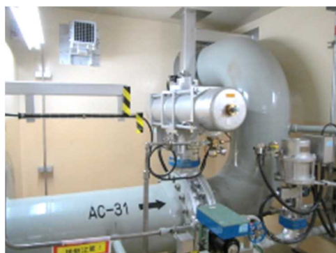
空気作動弁及び可とう電線管
