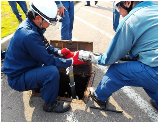
写真 4 消火栓接続
