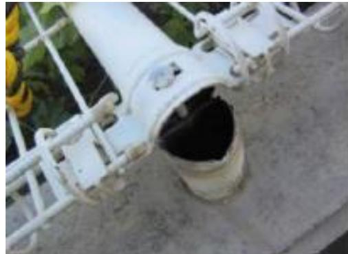
支柱部の破断
