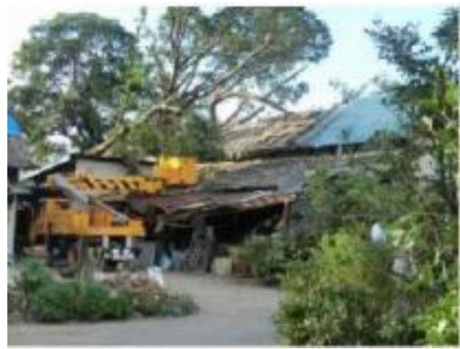
樹木の倒壊による小屋組の被害
