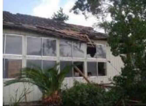
倉庫の窓ガラスと屋根の被害状況
