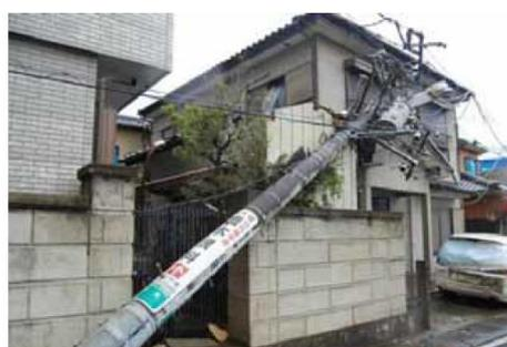
(電柱の折損、傾斜)
