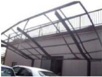
カーボード屋根の飛散及び骨組の損傷
