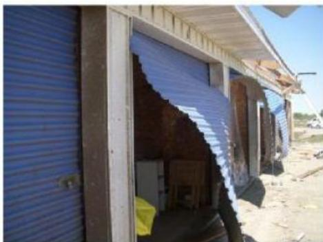
図 6 平成 20 年 5 月 25 日米国アイオワ州にて発生した EF5 竜巻によるシャッター被害状況<sup>(6)</sup>
