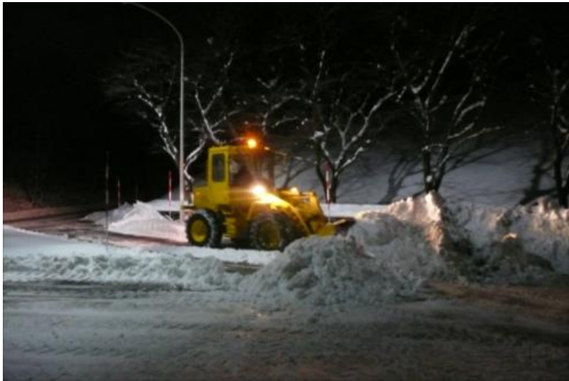
図 3-2(1) 重機による除雪作業
