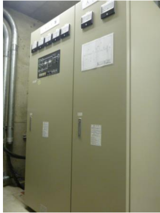
(無停電電源装置の写真)
