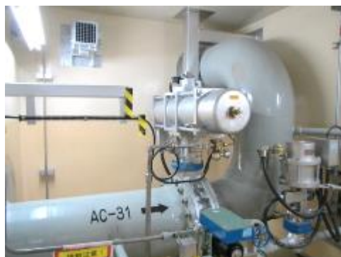
空気作動弁及び可とう電線管
