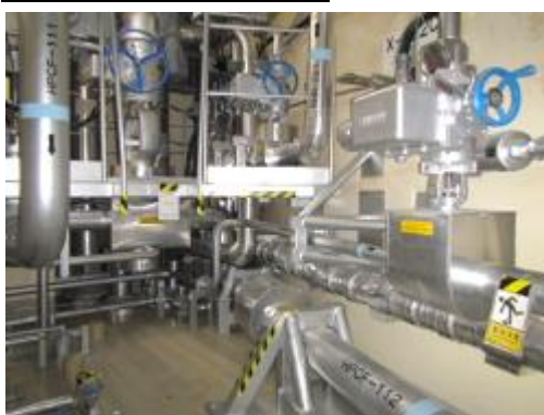
電動弁及び可とう電線管
