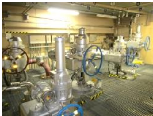
電動弁及び可とう電線管
