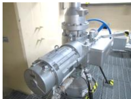
電動弁及び可とう電線管
