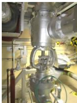
電動弁及び可とう電線管
