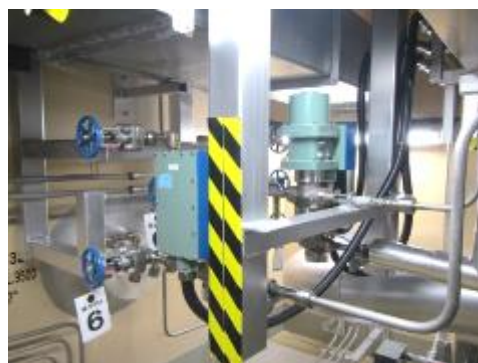
電磁弁及び可とう電線管
