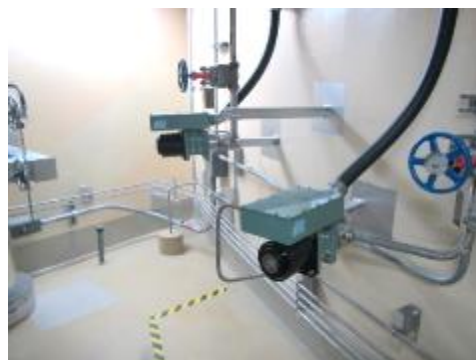
電磁弁及び可とう電線管
