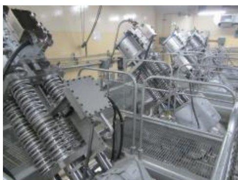
主蒸気隔離弁
