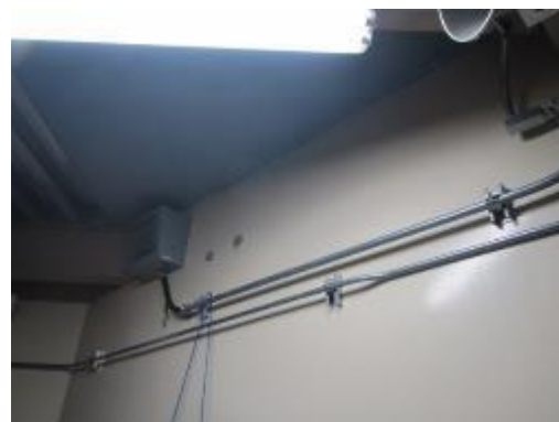
エリアモニタ及び可とう電線管
