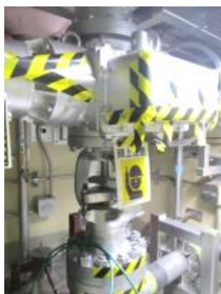
電動弁及び可とう電線管
