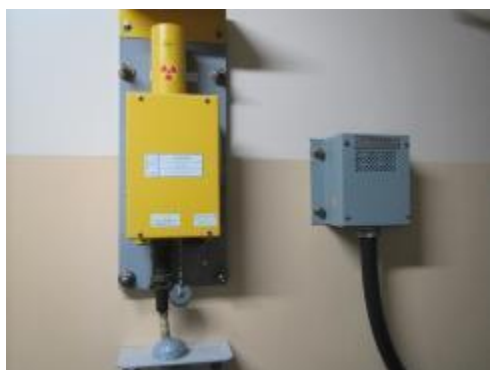
エリアモニタ及び可とう電線管
