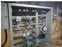
サンプリングトランスミッタ盤
