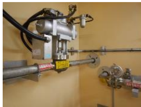
空気作動弁及び可とう電線管
