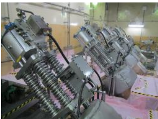
主蒸気隔離弁
