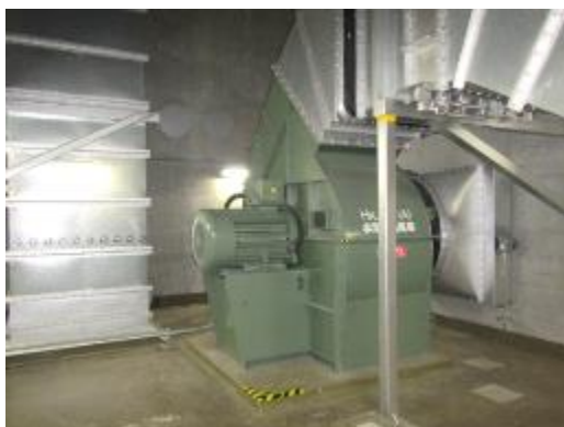
送風機，電動機及び可とう電線管
