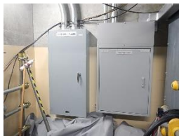
ケーブル分岐箱，分電盤
