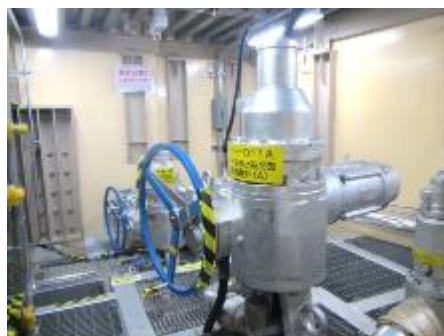
電動弁及び可とう電線管
