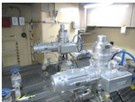
電動弁及び可とう電線管
