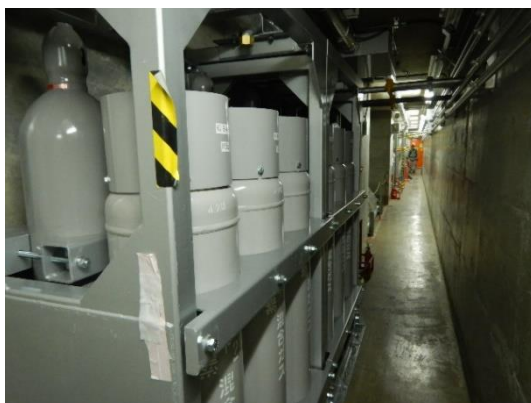
ポンベ及び配管
