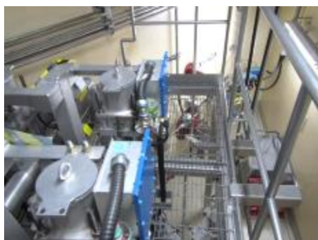
空気作動弁及び可とう電線管
