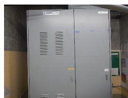
原子炉系多重伝送現場盤
