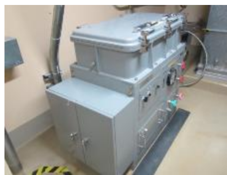
ダストサンプラ及び可とう電線管
