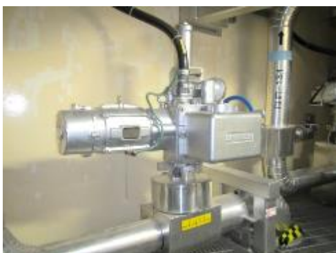
電動弁及び可とう電線管
