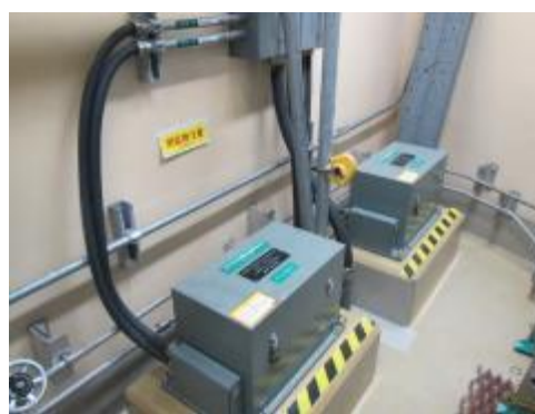
地震観測装置及び可とう電線管
