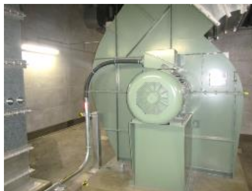
送風機，電動機及び可とう電線管
