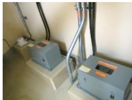
地震観測装置及び可とう電線管
