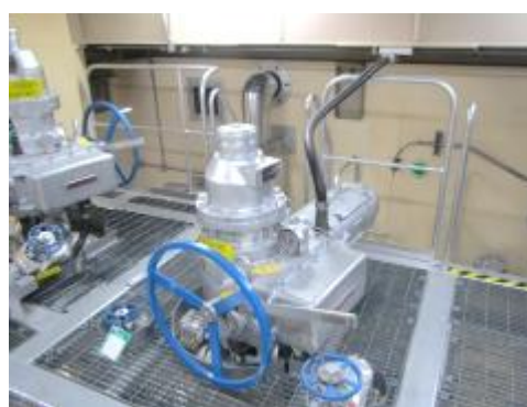
電動弁及び可とう電線管
