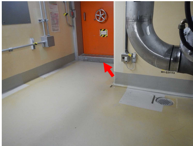
第 41-1-2 図：堰による拡大防止対策概要図
