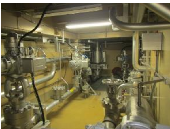
電動弁及び可とう電線管
