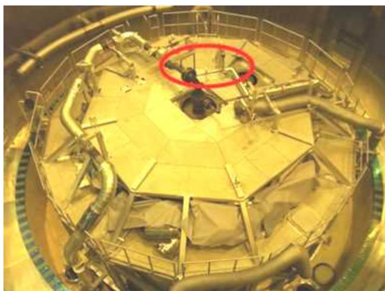
第 41-1-6 図：ベント配管の設置例
