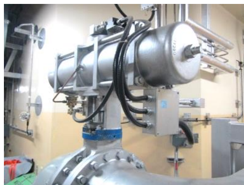
空気作動弁及び可とう電線管
