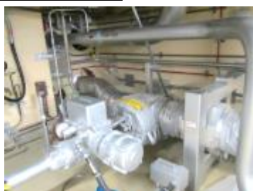
電動弁及び可とう電線管
