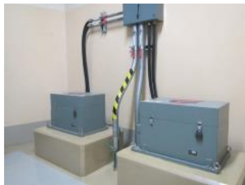
地震観測装置及び可とう電線管
