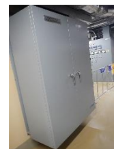
電磁弁盤
