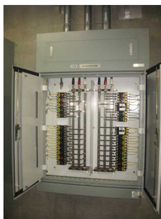
配線用遮断器の例 (ブレーカー)
