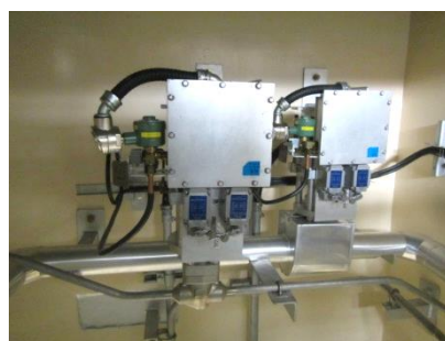
空気作動弁及び可とう電線管
