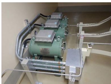
TIP 遮蔽容器及び可とう電線管
