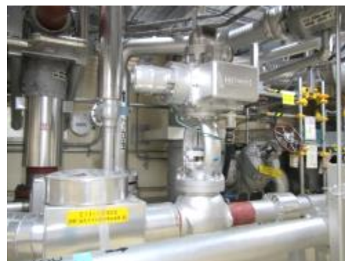
電動弁及び可とう電線管
