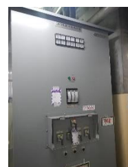
CRD 駆動水加熱器盤
