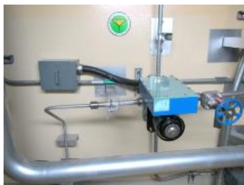
電磁弁及び可とう電線管
