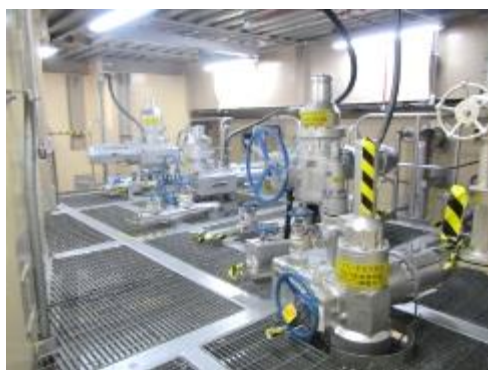
電動弁及び可とう電線管
