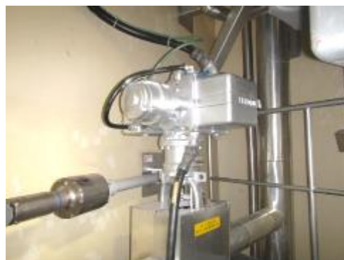
電動弁及び可とう電線管
