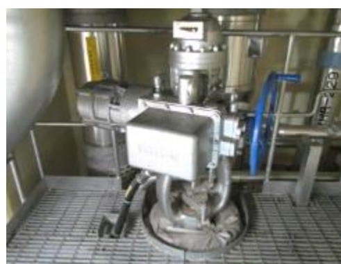
電動弁及び可とう電線管
