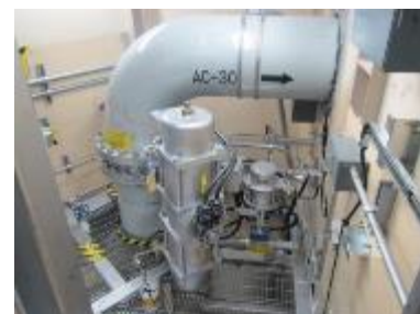
空気作動弁及び可とう電線管
