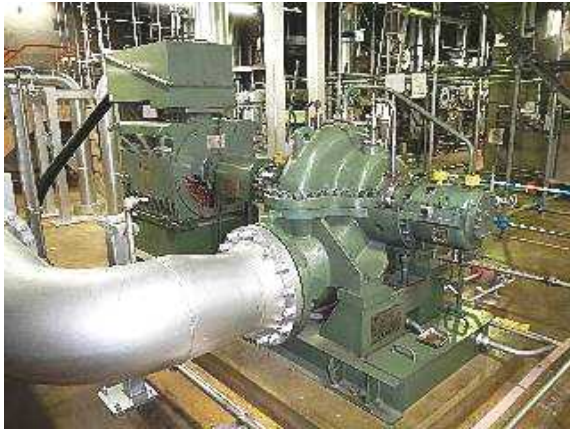
ポンプ，配管，支持構造物の例
