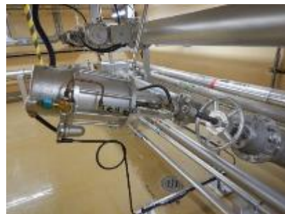
空気作動弁及び可とう電線管
