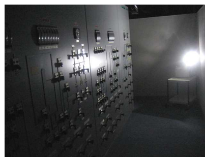
図 2.5-7 裏盤における可搬型蓄電池内蔵型照明確認状況
