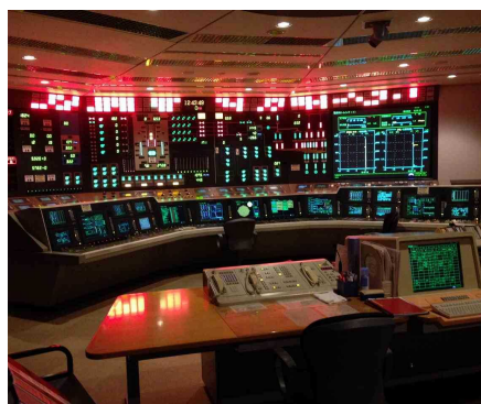
(直流非常灯照明点灯状態)
