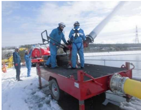
放水砲による放水の状況
