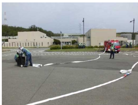
ホースを建屋接続口まで敷設
