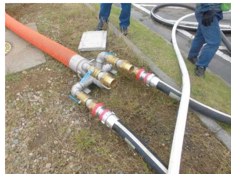
ホース接続治具との接続 (防火水槽周辺)
