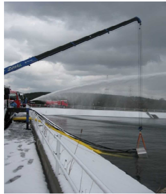
取水ポンプ設置の状況
