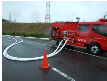
可搬型代替注水ポンプ（先車）の 設置（タービン建屋周辺）
