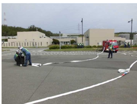
ホースを建屋接続口まで敷設
