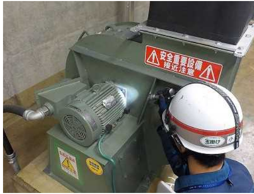
空調機起動状態確認
