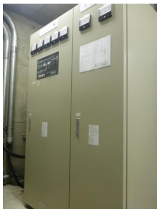
(無停電電源装置の写真)
