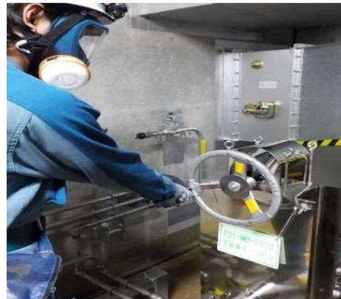
系統構成（遠隔手動弁操作設備）
