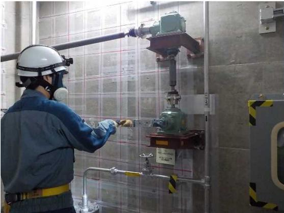
系統構成（遠隔手動弁操作設備）
