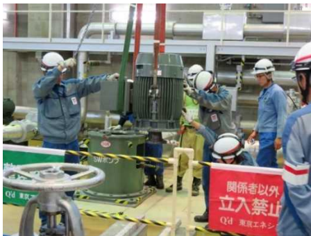
直営による豎型ポンプ用電動機を取替作業
