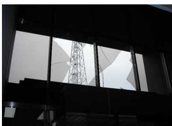
窓ガラスの破損
