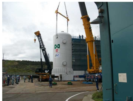
フィルタベント設備の搬入・設置 (柏崎刈羽原子力発電所7号炉)
