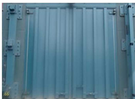
建屋扉 (従前のもの)
