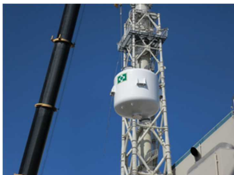
よう素フィルタの搬入・設置 (柏崎刈羽原子力発電所7号炉)
