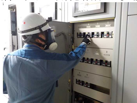
直流電源延命のための負荷カット手順に基づいた操作訓練（柏崎刈羽原子力発電所）
