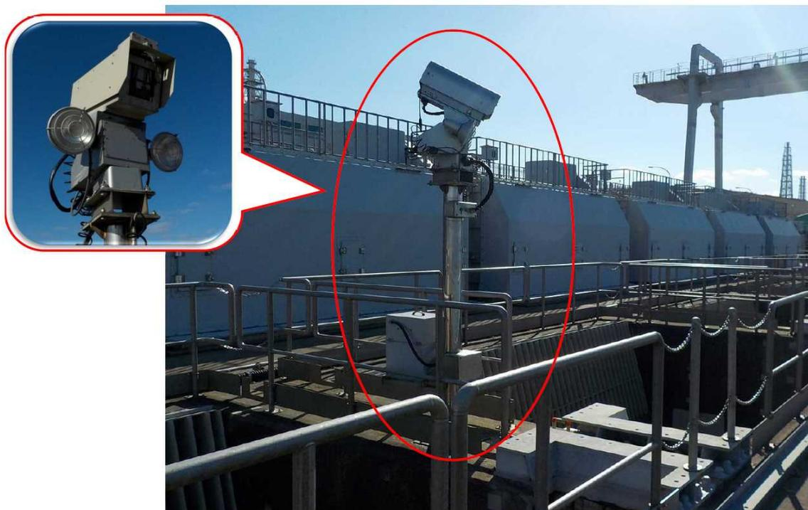
図 2.1-8 構内監視カメラ取り付け概要図
