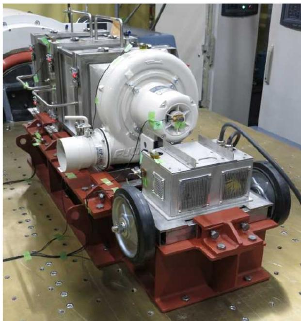
図4-3 5号炉原子炉建屋内緊急時対策所（対策本部）可搬型陽圧化空調機，可搬型外気取入送風機 設置状態外観
