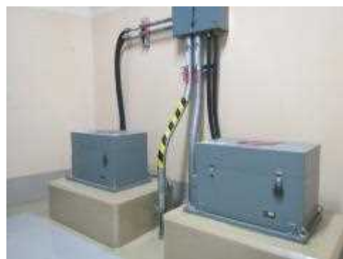
地震観測装置及び可とう電線管
