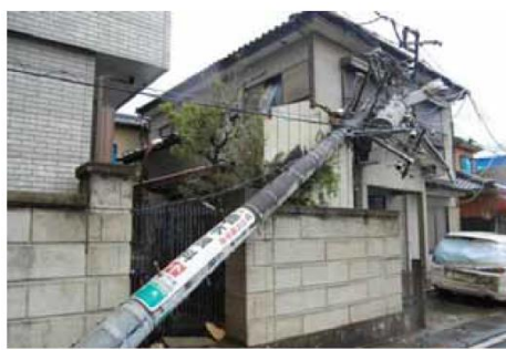
(電柱の折損、傾斜)
