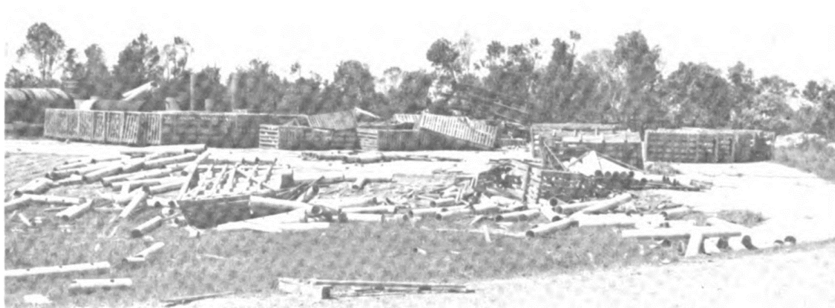
第26図 Grand Gulf 原子力発電所資材置き場におけるパイプの散乱状況
