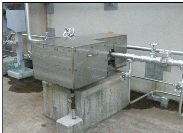
図 5-2 燃料移送ポンプ外形写真
