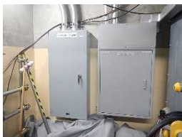
ケーブル分岐箱，分電盤
