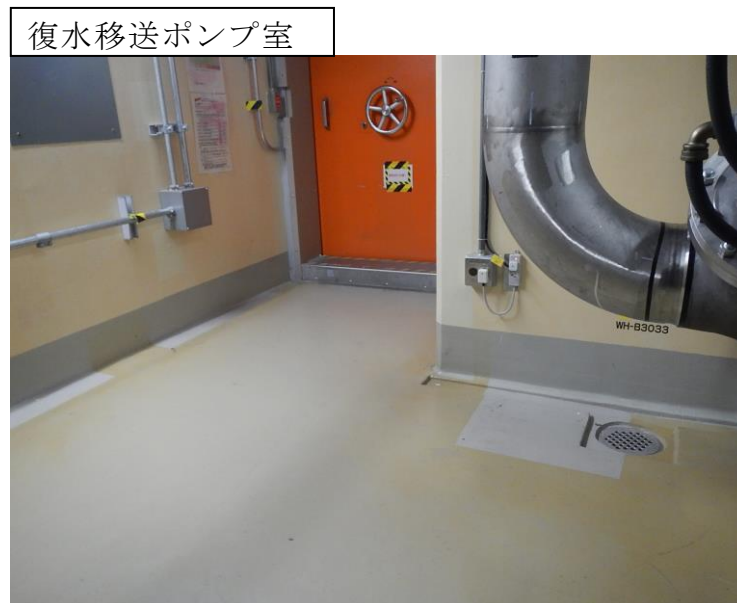
第 1-2 図：堰による拡大防止対策概要図
