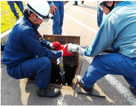
写真 4 消火栓接続
