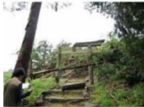
倒木の折損と鳥居の被害
