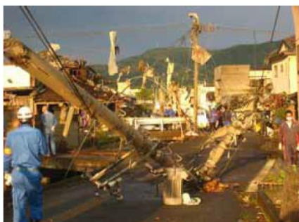
(電柱の折損、傾斜)
