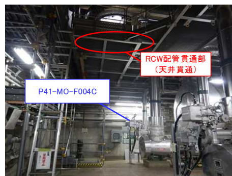
P41-MO-F004C 現場状況
