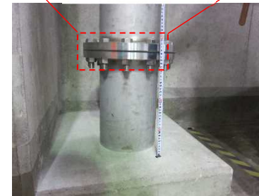
e 部 ベント管接合フランジ部
