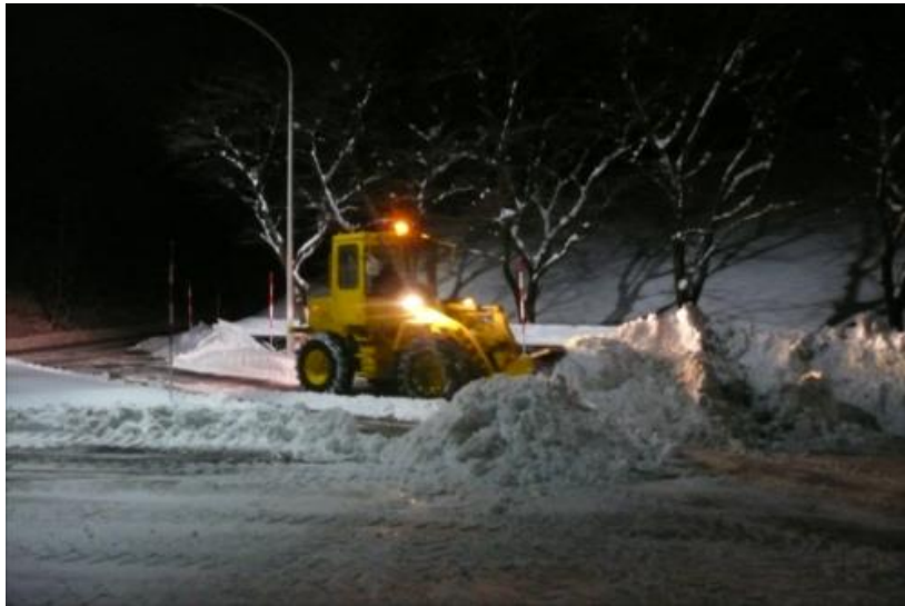
図 3-2(1) 重機による除雪作業
