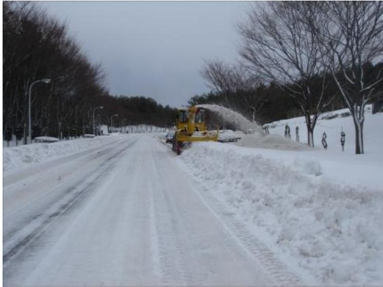
図 3-2(3) 重機による除雪作業
