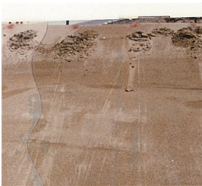
2号造成北側法面 (新期砂層・沖積層拡大)
