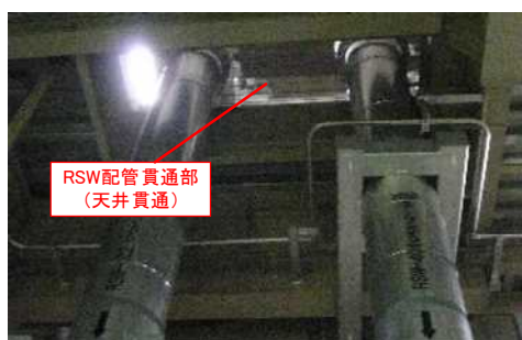
原子炉補機冷却海水系配管貫通部 (天井貫通) 現場状況
