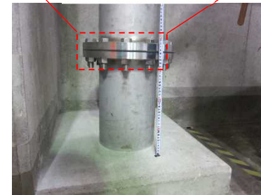
e 部 ベント管接合フランジ部
