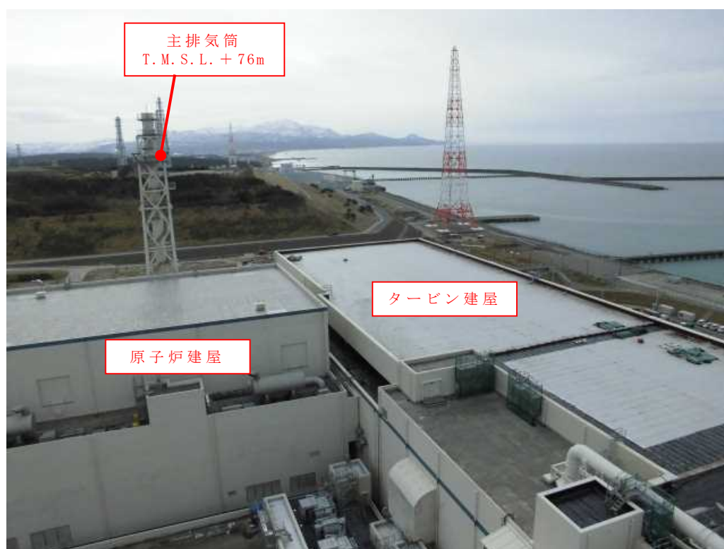
第 4.3-2 図 津波監視カメラ設置位置
