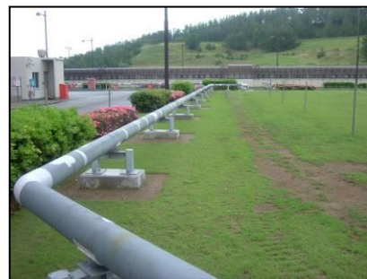
消火配管の地上化
