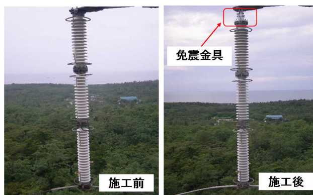
第2.2.4-13図 免震金具取付の施工状況
