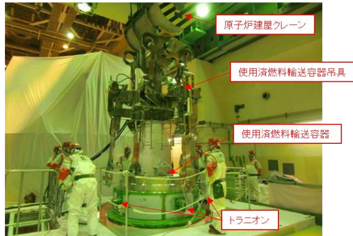
第1図 使用済燃料輸送容器吊具の現場での使用状況 (7号炉の原子炉建屋クレーンを使用する場合)
