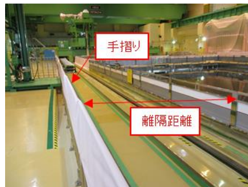
使用済燃料プールとの離隔の概要
