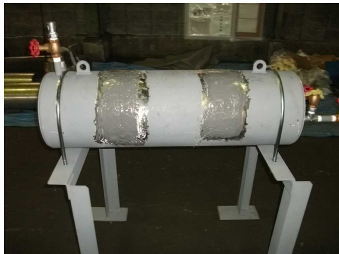
図 2.1.2-6 ベロメタル補修後の耐圧試験
