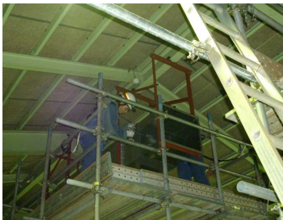
図 2.1.4-8 ダクト修復 作業訓練の例
