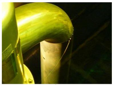
図1 サイフォンブレーク孔の設置状況
