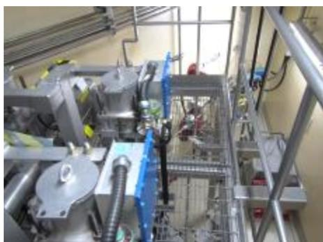
空気作動弁及び可とう電線管
