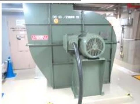
電動機及び可とう電線管
