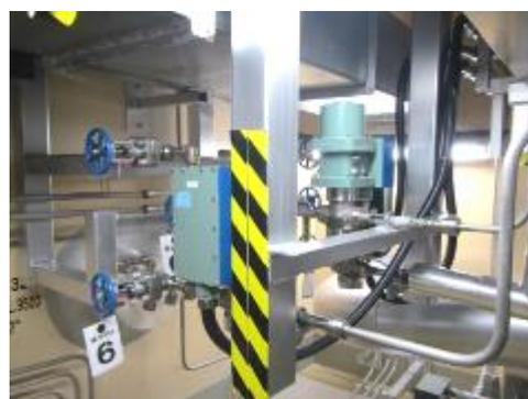
電磁弁及び可とう電線管
