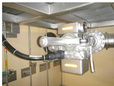
電動弁及び可とう電線管
