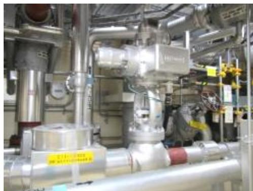
電動弁及び可とう電線管
