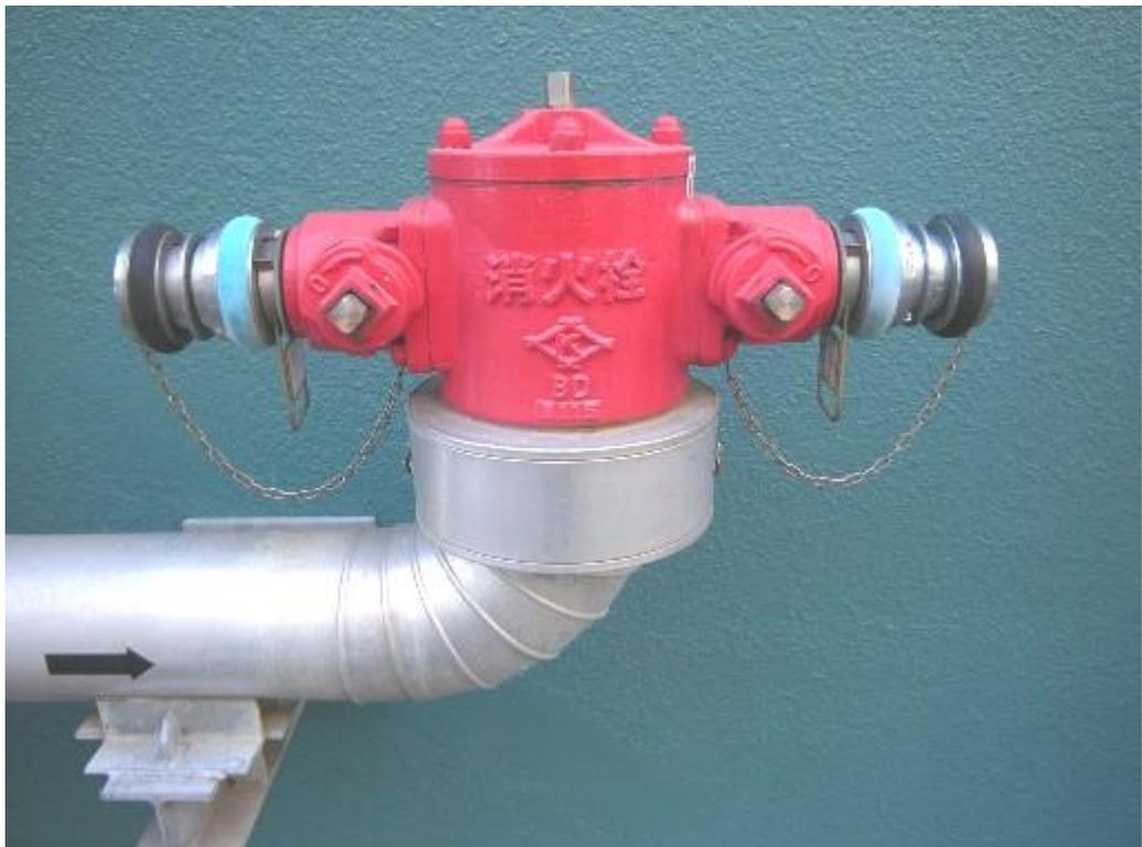
第 41-1-35 図：不凍式消火栓の設置状況
