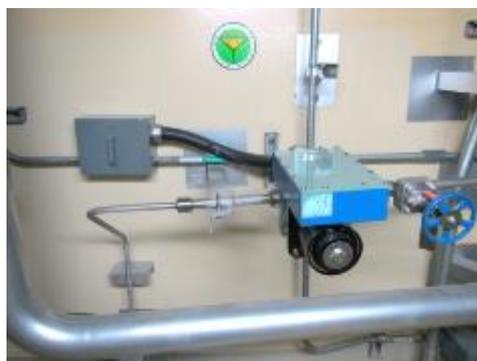
電磁弁及び可とう電線管
