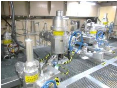
電動弁及び可とう電線管
