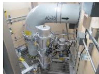
空気作動弁及び可とう電線管
