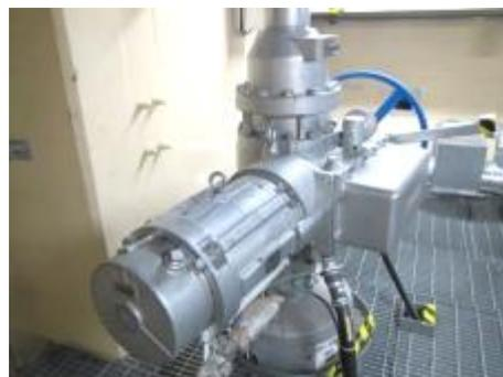
電動弁及び可とう電線管
