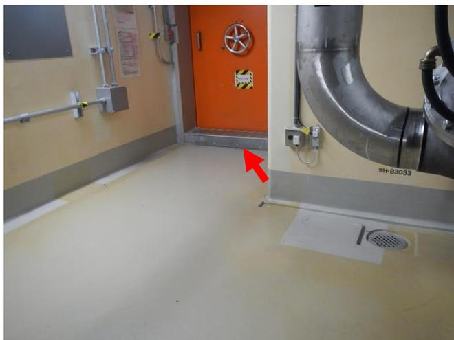
第 41-1-2 図：堰による拡大防止対策概要図
