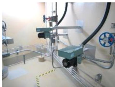
電磁弁及び可とう電線管
