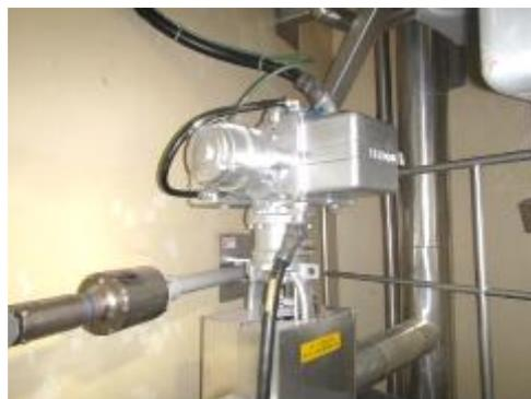
電動弁及び可とう電線管
