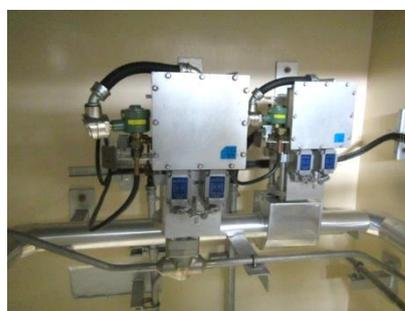
空気作動弁及び可とう電線管
