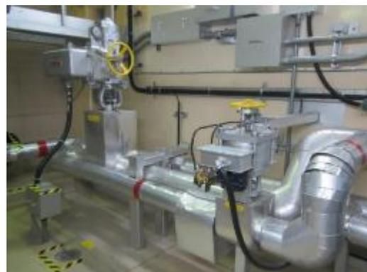
電動弁及び可とう電線管
