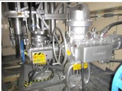
電動弁及び可とう電線管
