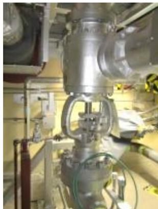
電動弁及び可とう電線管
