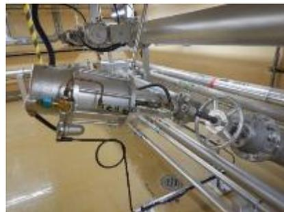
空気作動弁及び可とう電線管
