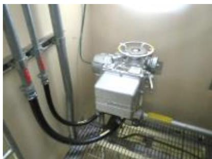
電動弁及び可とう電線管
