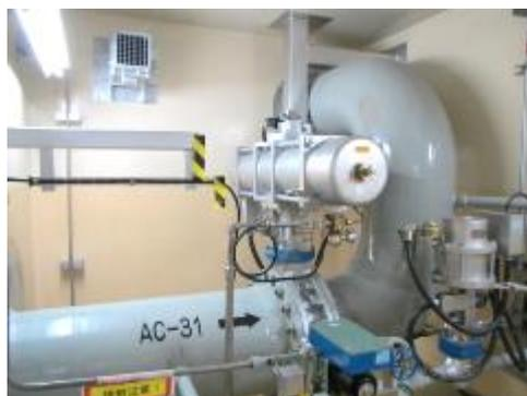
空気作動弁及び可とう電線管
