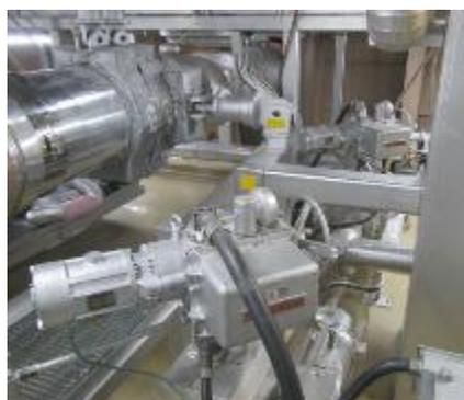
電動弁及び可とう電線管
