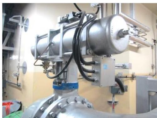
空気作動弁及び可とう電線管
