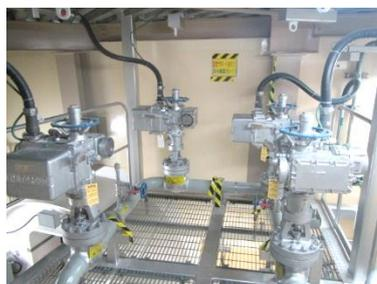
電動弁及び可とう電線管
