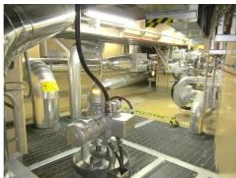
電動弁及び可とう電線管
