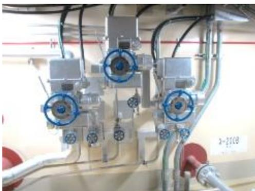
電動弁及び可とう電線管
