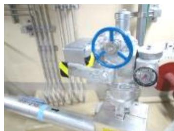
電動弁及び可とう電線管
