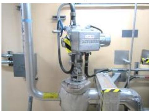
電動弁及び可とう電線管
