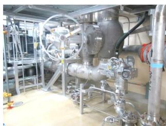
電動弁及び可とう電線管
