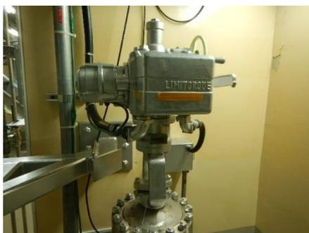
電動弁及び可とう電線管
