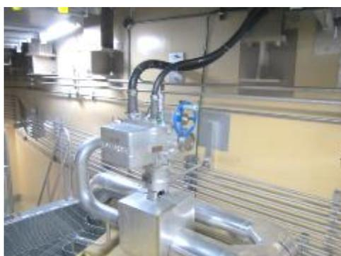
電動弁及び可とう電線管
