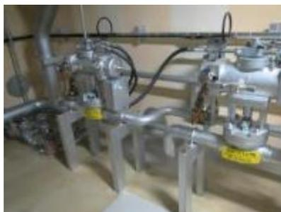
電動弁及び可とう電線管
