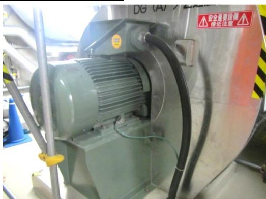
電動機及び可とう電線管
