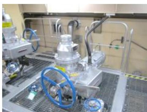
電動弁及び可とう電線管
