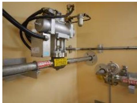
空気作動弁及び可とう電線管
