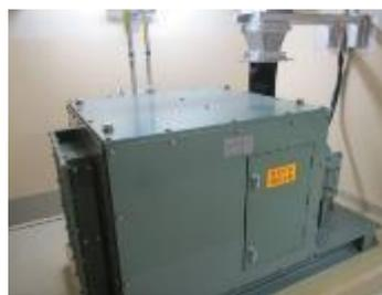
電動機及び可とう電線管
