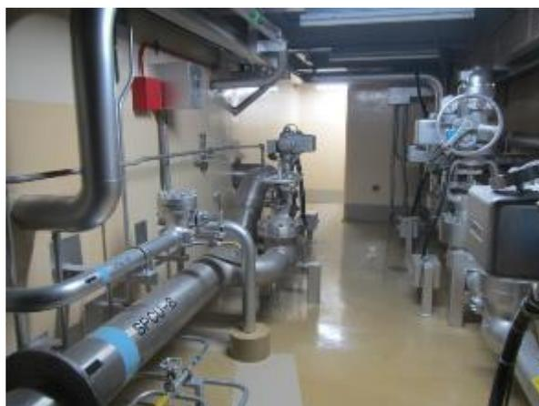
電動弁及び可とう電線管
