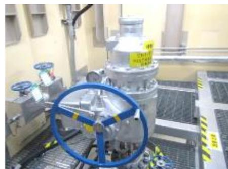
電動弁及び可とう電線管
