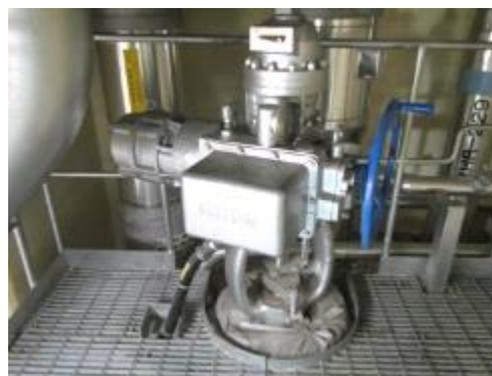
電動弁及び可とう電線管
