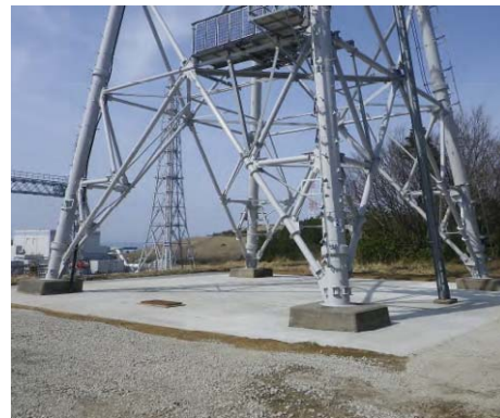
南新潟幹線 No. 1 送電鉄塔
