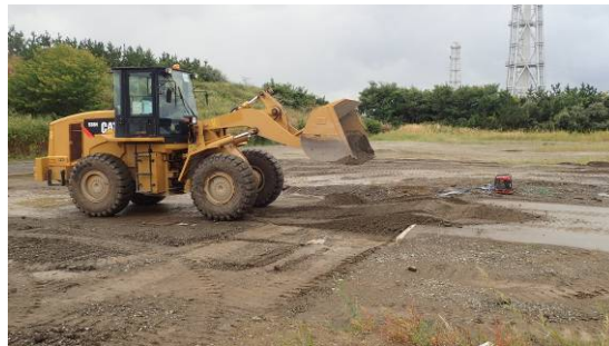
段差復旧状況③
