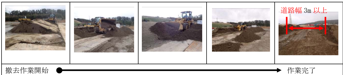
第 10 図 土砂撤去状況写真
