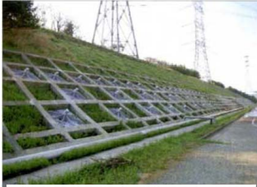
超高圧開閉所東側法面
