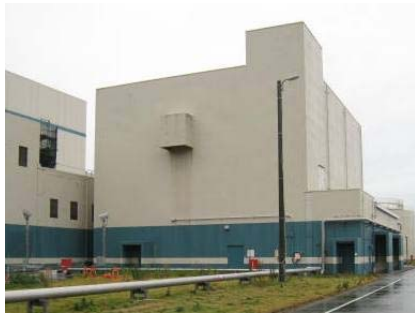
雑固体廃棄物焼却設備建屋（大湊側）
