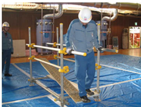
福島第一原子力発電所における新入社員に対する研修（足場危険体感）
