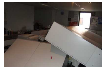
什器の転倒（2階事務室）
