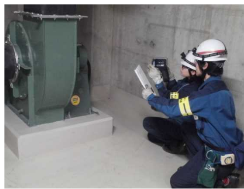
運転員の直営によるデータ採取（電動機の赤外線サーモグラフィ診断）
