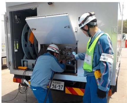
電源車の起動操作訓練
