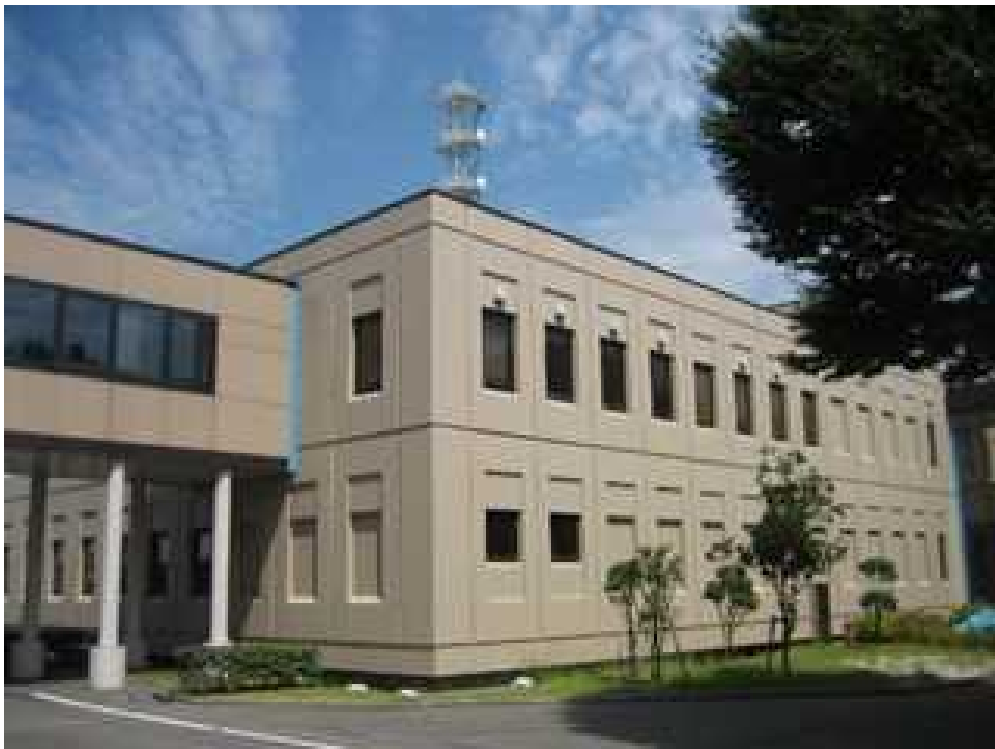
発災直後の事務所本館建物
