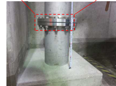
e 部 ベント管接合フランジ部
