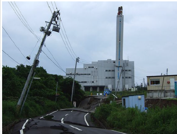
第 11-11-31 図 河道沿いの道路被害 （土木学会（2010））
