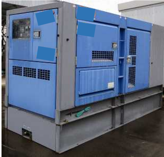
图 4-14 5号炉原子炉建屋内緊急時対策所用可搬型電源設備 外觀
