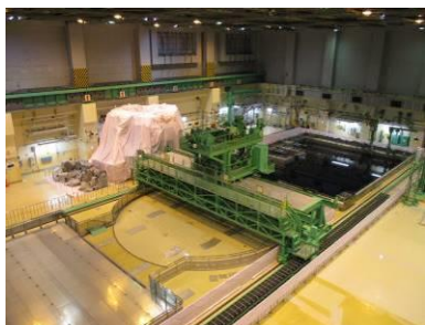
原子炉建屋オペレーティング フロアの床面全体
