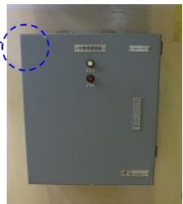
ボルトによる壁面固定
