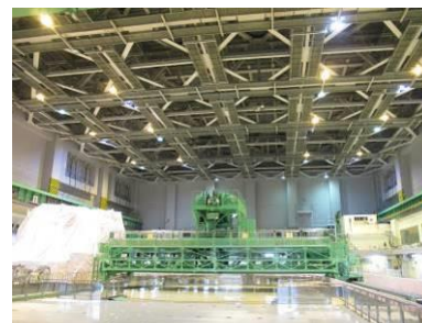
使用済燃料プール上部天井
