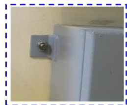
ボルトによる壁面固定
