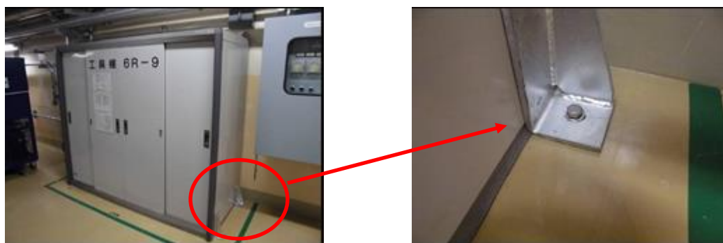
補足第 6.3.1.2-2 図 固縛処置例【6号炉原子炉建屋 工具棚】
