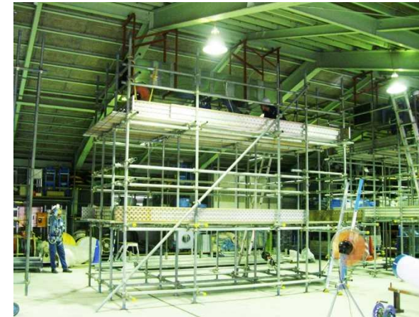
図 2.1.4-8 ダクト修復 作業訓練の例
