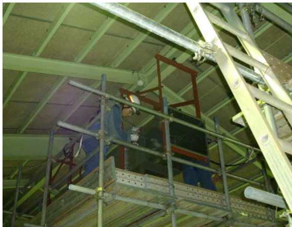
図 2.1.4-8 ダクト修復 作業訓練の例
