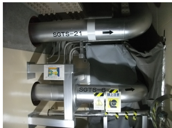
配管補修箇所（可搬型照明2台使用）
